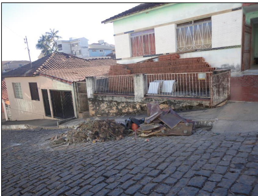
Figura 12.1 – Entulho de construção civil em rua da sede urbana de Espírito Santo do Dourado/MG.
